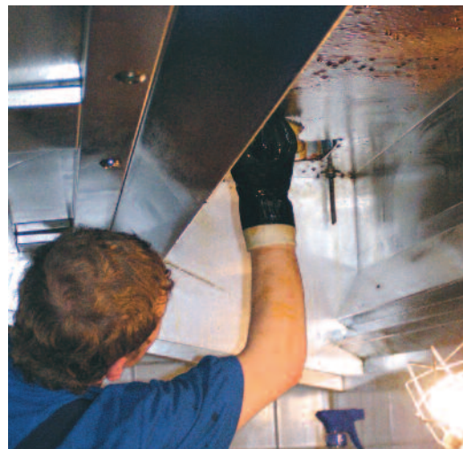
Nach der Dampfreinigung muss noch Hand angelegt werden
