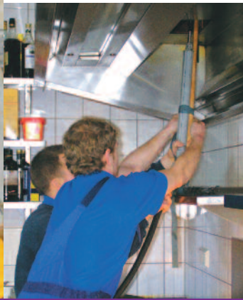
30 cm tief wird die Pistole des Dampfreinigers in das Abluftrohr gesteckt
